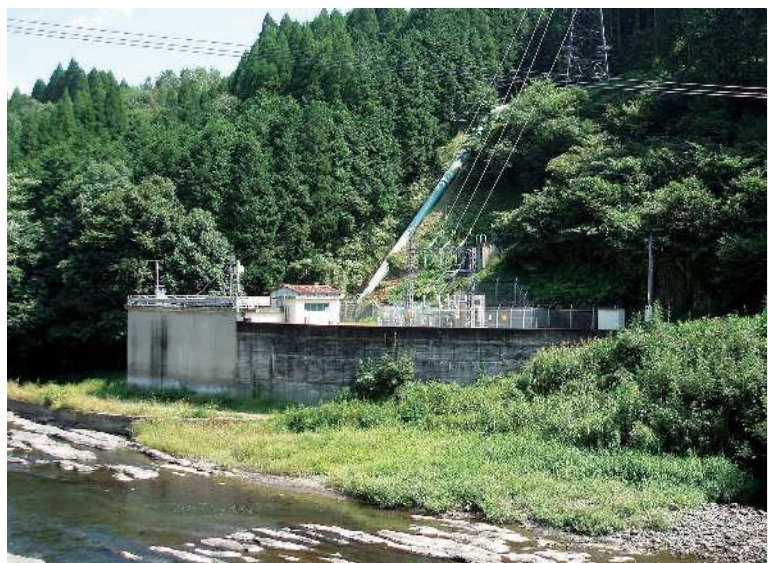
芹川第三発電所
