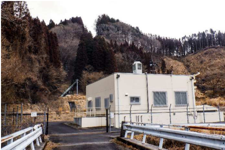
鳴子川発電所
