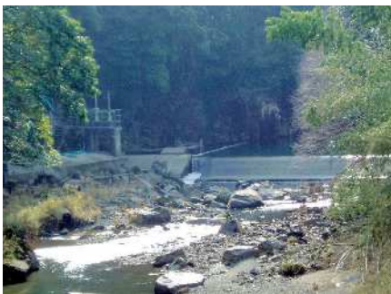
三重川取水堰
