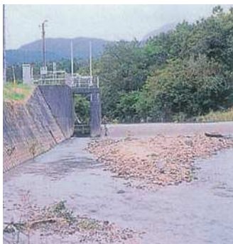
白水川取水堰
