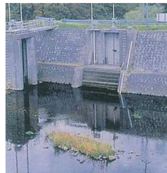
鳴子川取水堰
