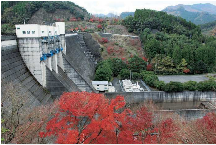
耶馬溪発電所
