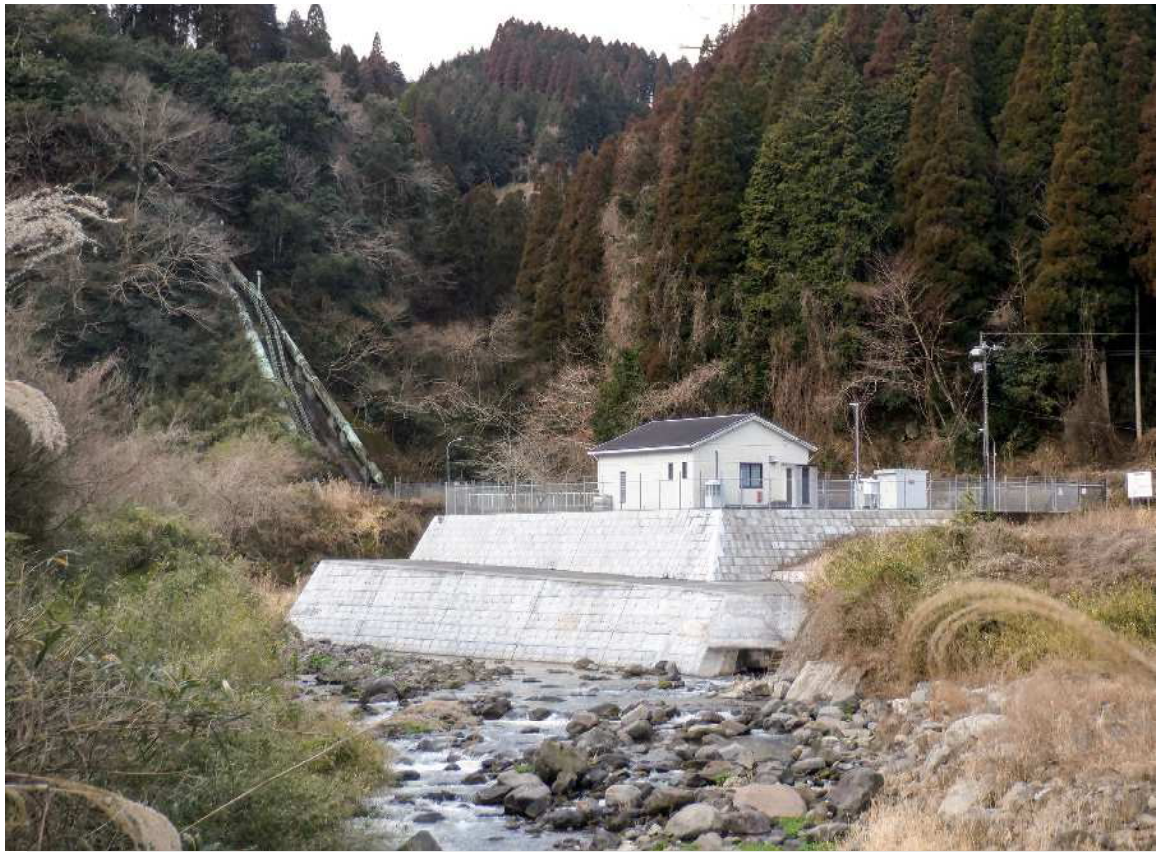
阿蘇野川発電所
