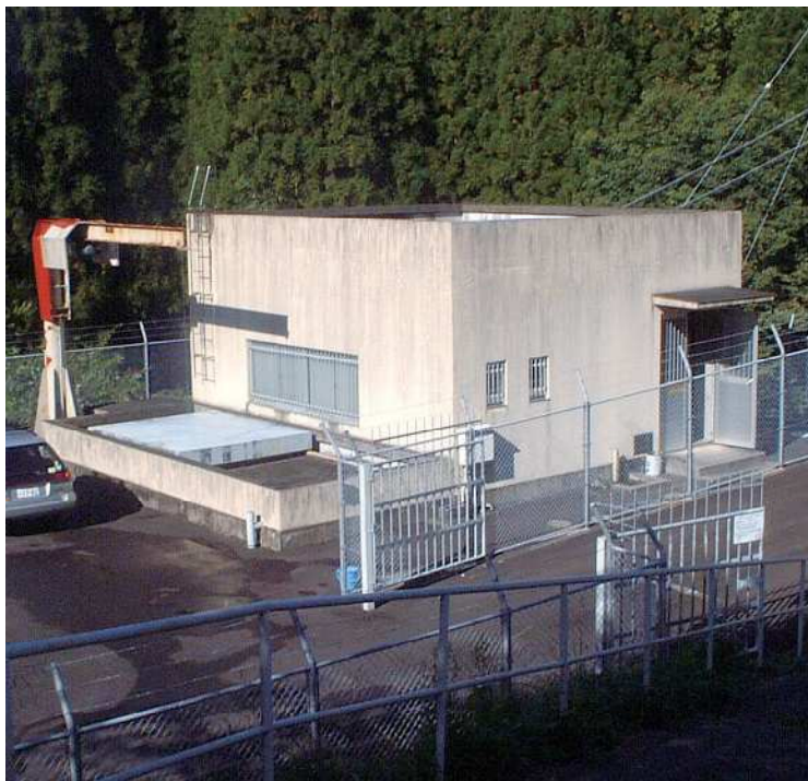
花合野川発電所
