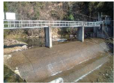
小狭間川取水堰
