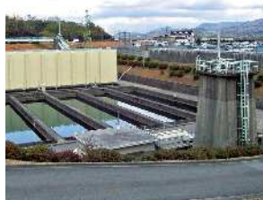
判田取水場 (中央が沈砂池)
