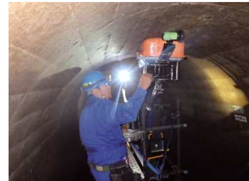
送水隧道点検中(火振志村線)
