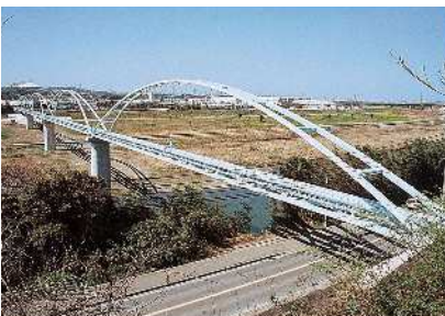
大野川松岡水管橋
