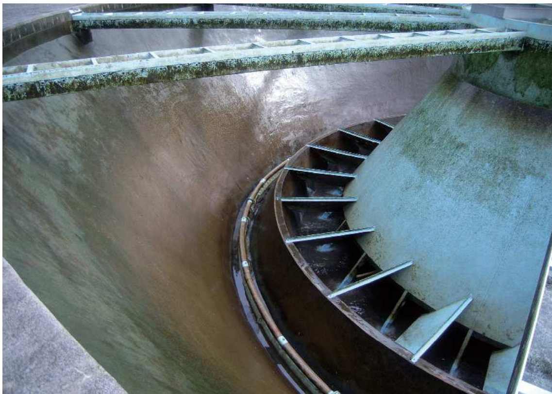
沈殿池清掃作業中
