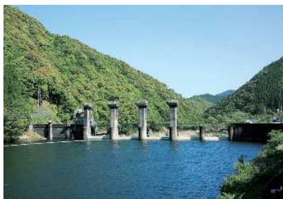
下赤逆調整池ダム
