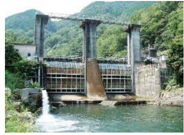
逆調整池ダム
