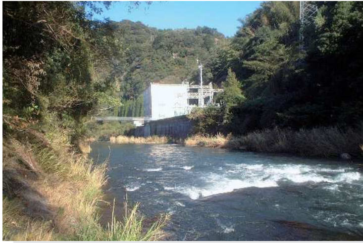
芹川第二発電所
