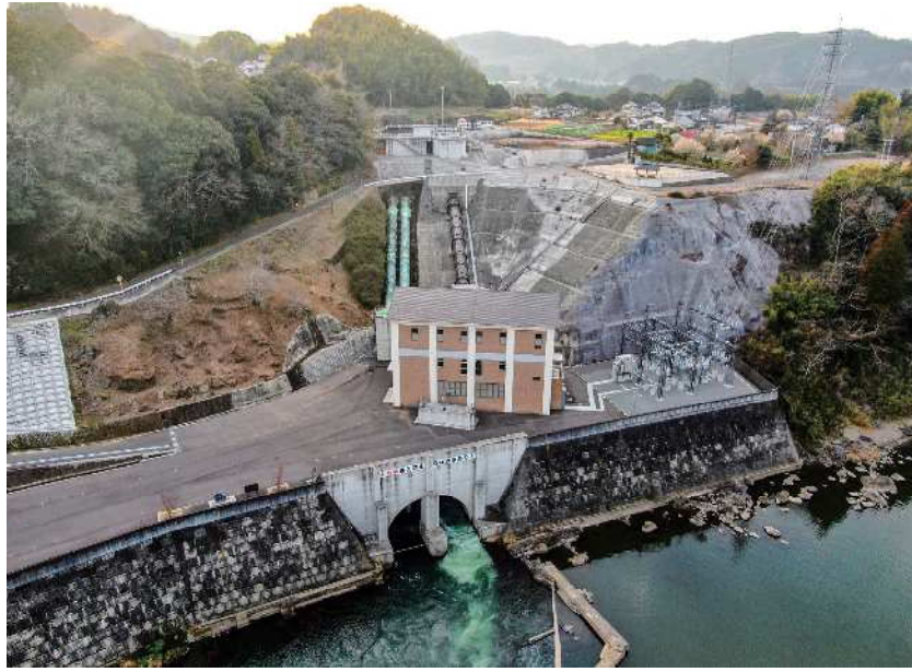
大野川発電所
