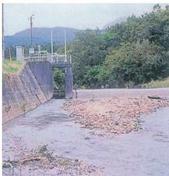
白水川取水堰
