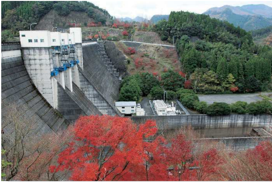
耶馬溪発電所
