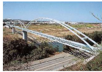
大野川松岡水管橋
