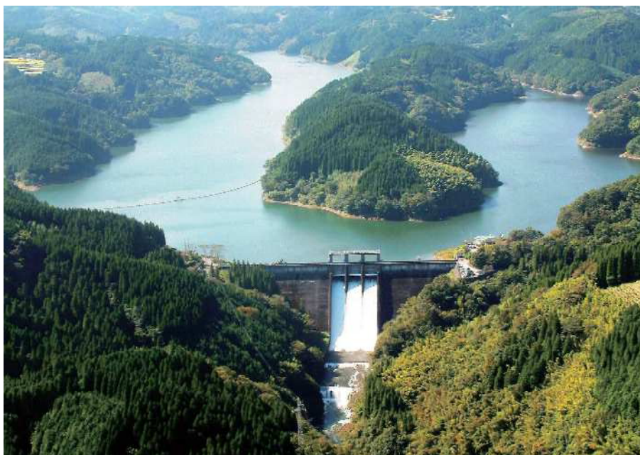
芦川ダム（左岸：竹田市、右岸：大分市）
