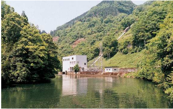
芹川第一発電所
