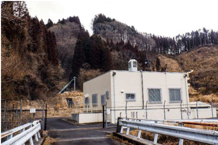
鳴子川発電所
