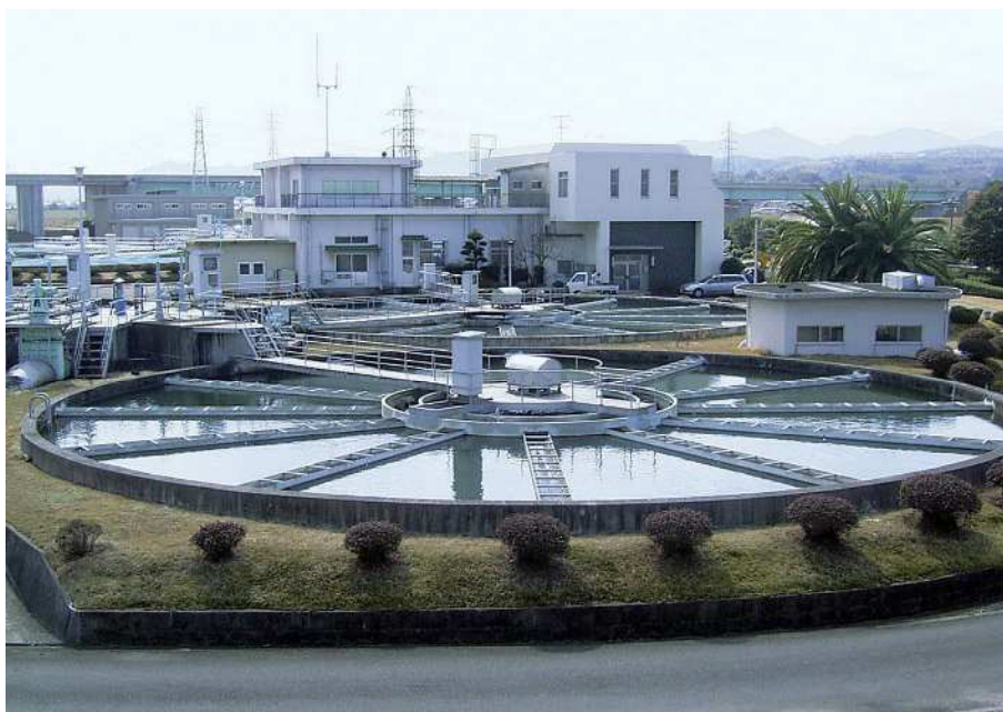
大津留浄水場（大分市）
