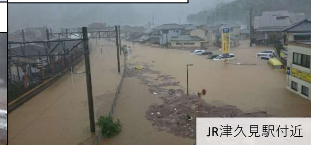
被災状況 (H29.10)
