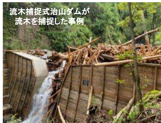
治山事業の実施による流木・土砂の流出抑制効果
