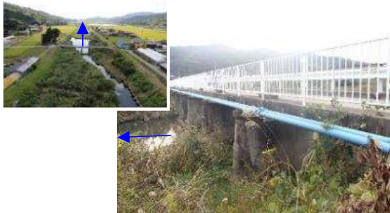
武蔵川(整備済区間)
