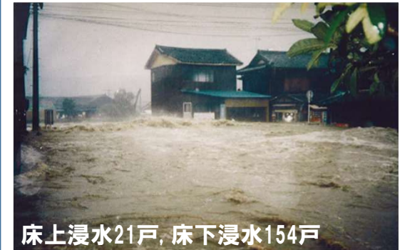
武蔵川浸水写真(H10年10月)
