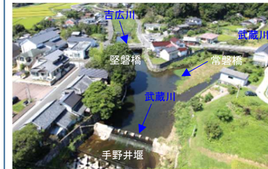
武蔵川(整備済区間)
