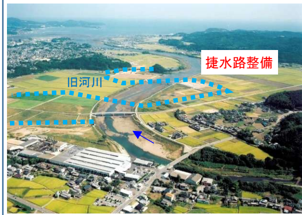
八坂川(整備済区間)
