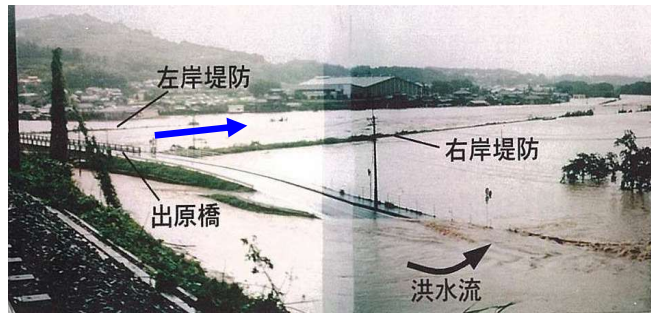
八坂川浸水写真(H9年9月)
