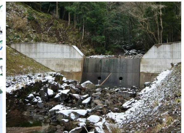
土砂を捕捉した治山ダム
