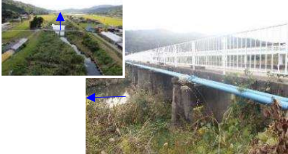
武蔵川(整備済区間)
