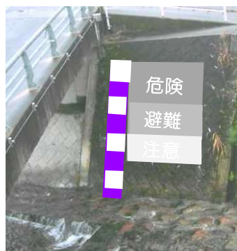
[設置後(通常時)]
