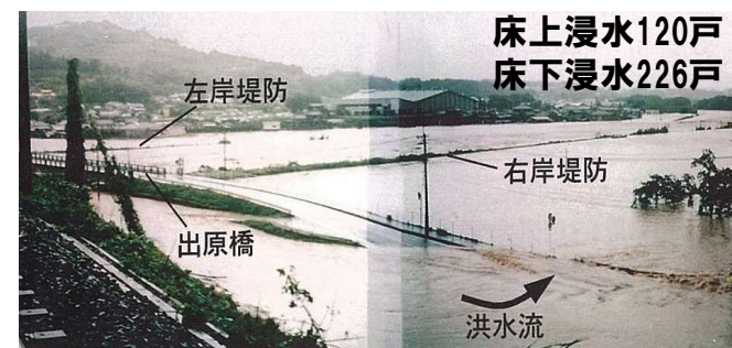
八坂川浸水写真(H9年9月)
