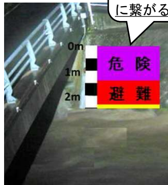
[設置後(増水時)]
