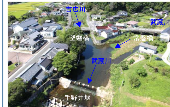
武蔵川(整備済区間)
