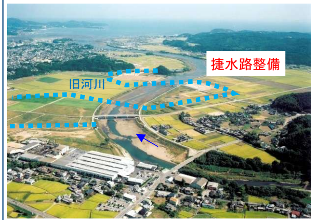
八坂川(整備済区間)
