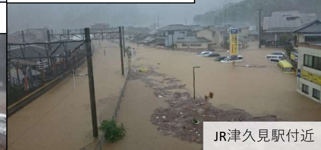
被災状況 (H29.10)
