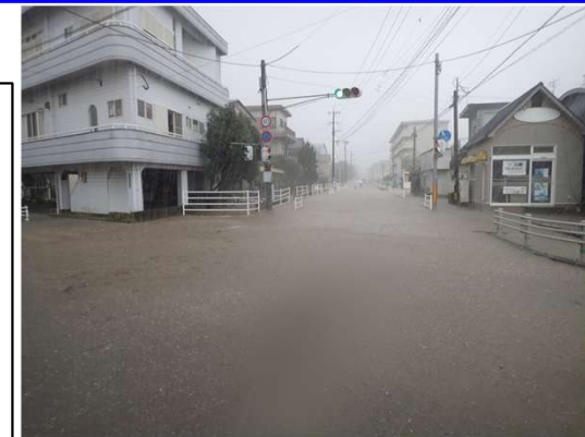
平成29年9月17日台風18号による内水被害
