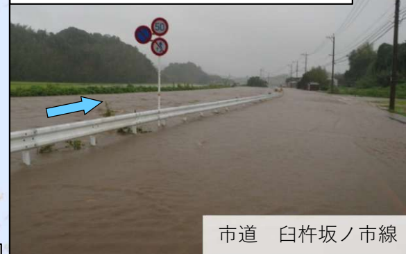
熊崎川 浸水状況 (H23.9)
