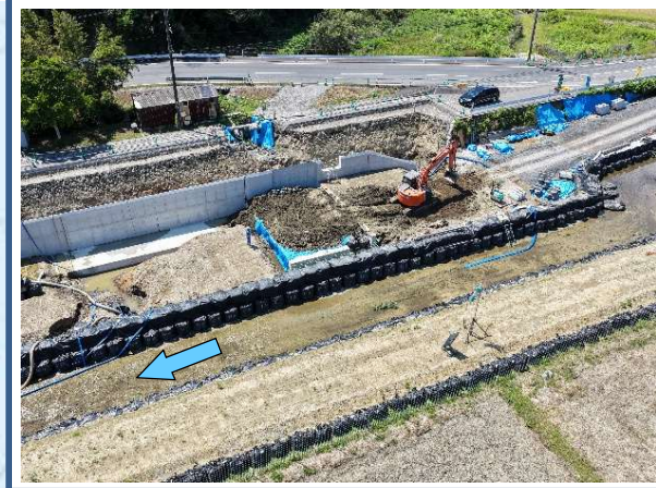
熊崎川(整備中区間)
