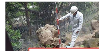
災害時要配慮者 関連施設の上部 での落石捕捉状況
