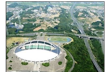
大規模な広域防災拠点(大分スポーツ公園)
