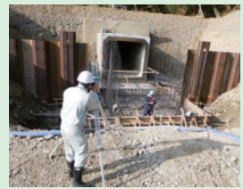
樋門改築工事の監督 測量の様子
