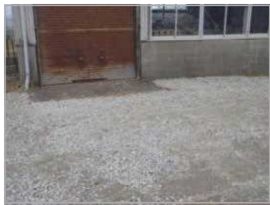
写真3 再生クラッシュランを敷設した 倉庫入口前
