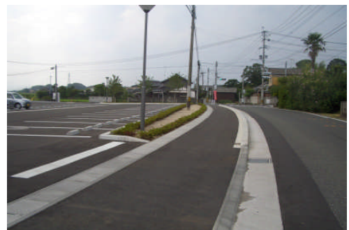
古森隣保館改修
