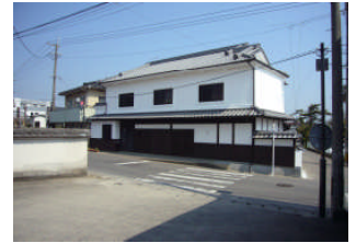
修景施設整備
