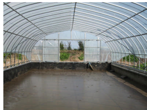
図3 ハウスを設置した砂ろ床
