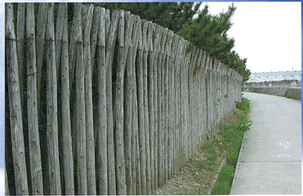
写真2 防風垣工 (佐賀関町)
