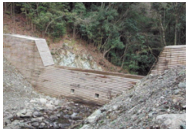
丸太型枠工（ダム工）
