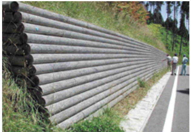
木製土留工（林道）
