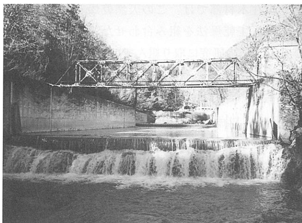
群馬県宝川森林理水試験地 (矩形直線開水路 L=40m, W=14m, H=3.5m)
