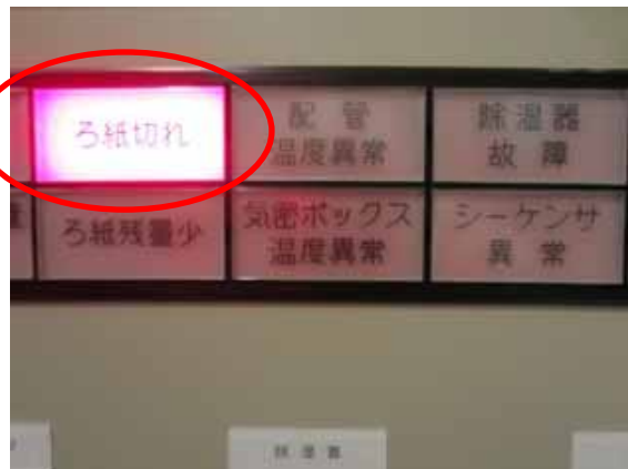
R - Z 5 0 1 焼却炉排気筒じんあいモニタ（現地盤警報）
