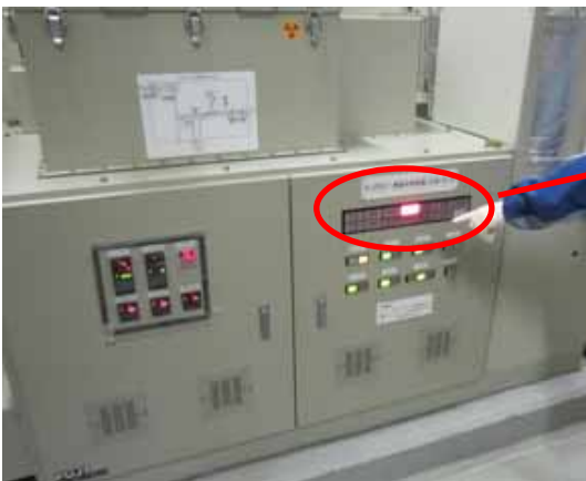
R - Z 5 0 1 焼却炉排気筒じんあいモニタ（現地盤警報）
