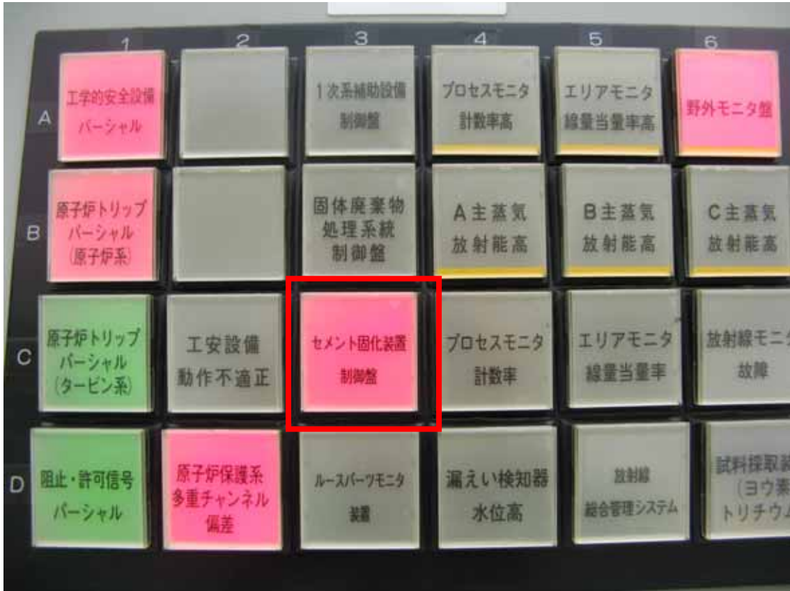
3号機中央制御盤
