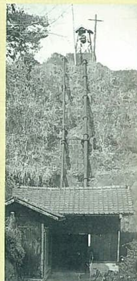
当時の草深野揚水場
