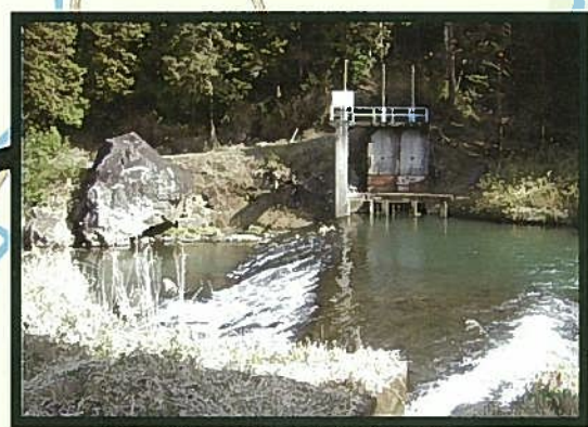
大野川頭首工
