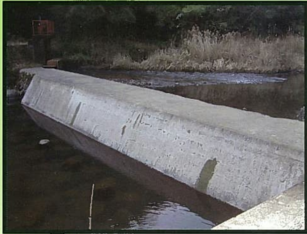
山崎補水線頭首工
