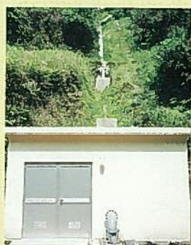
現在の第1発電所
