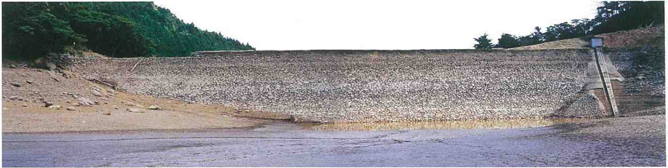
俊長が築造した富水池（改修前の姿）
