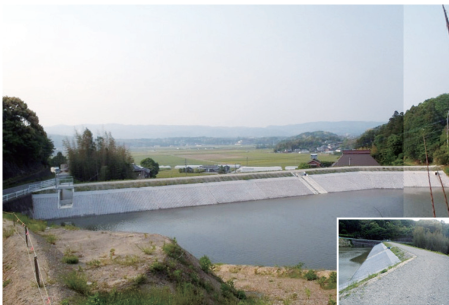
「地域全体の防災安全度向上」 防災ダム事業（今宮下池地区）
