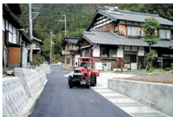
集落道と農道の一体的な整備
