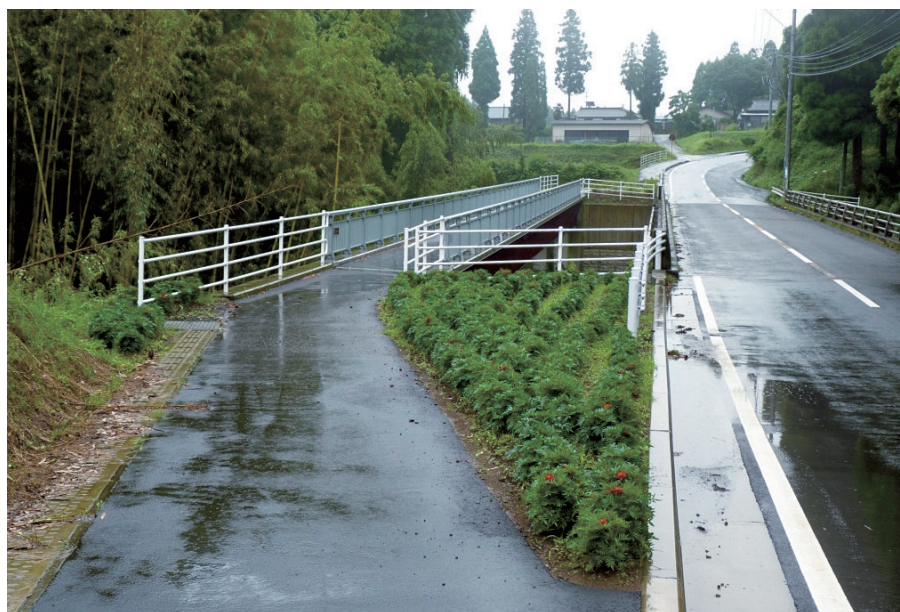
「完成！尾元歩道橋」 中山間地域総合整備事業（荻地区）
