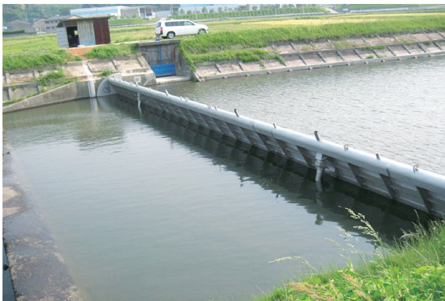
「21haの水田を潤す転倒ゲートの完成」 農業用河川工作物応急対策事業（塩屋地区）
