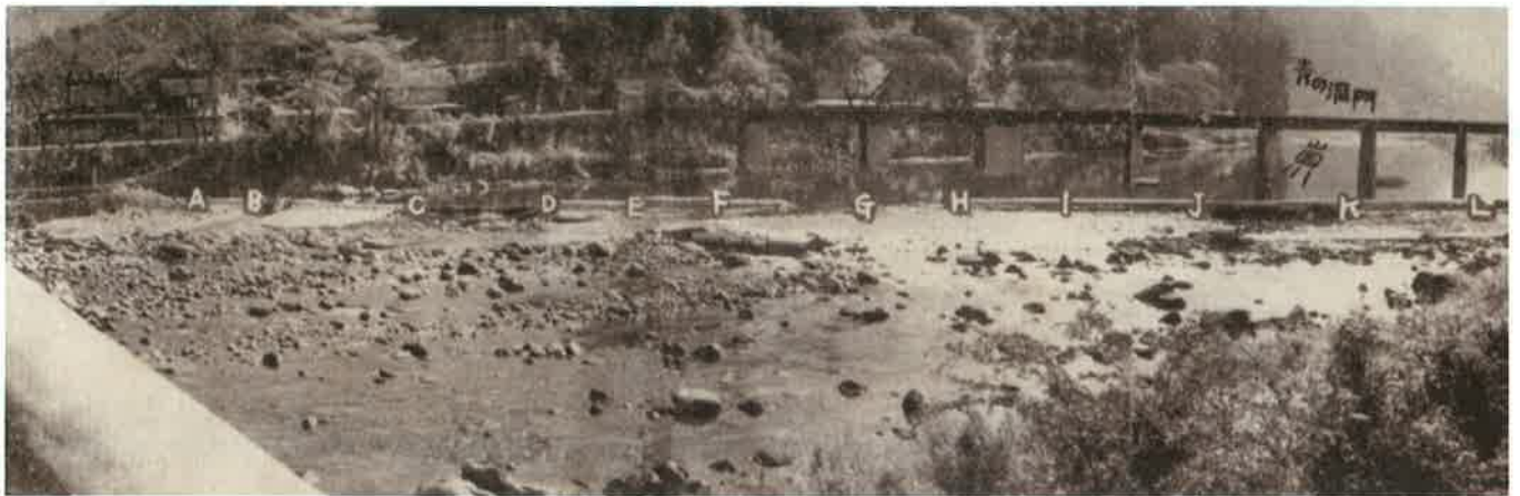
改修前の旧井堰
