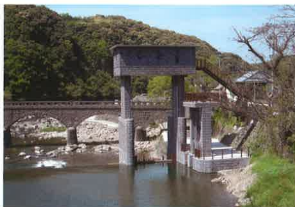
新しくなった頭首工（平成 11 年）
