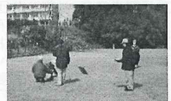
仮設住宅建設用調査 (東日本大震災)
