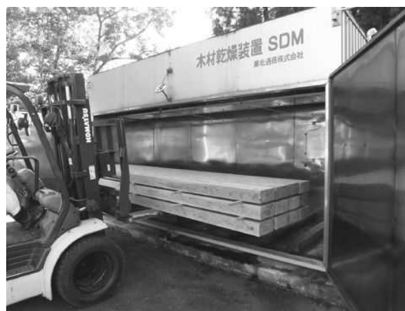
写真-1 木材乾燥装置での作業状況
