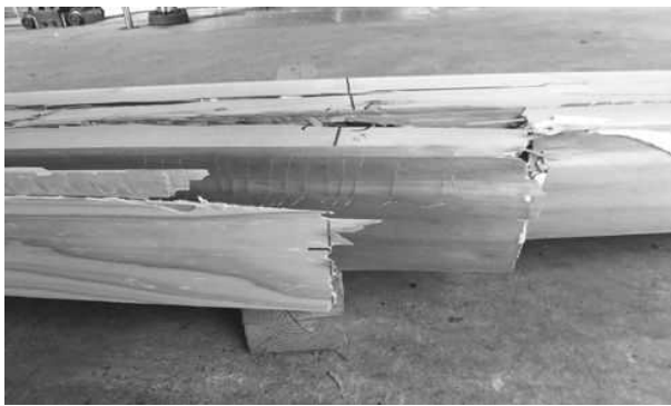
写真-5 引張破壊（下部）の状況
