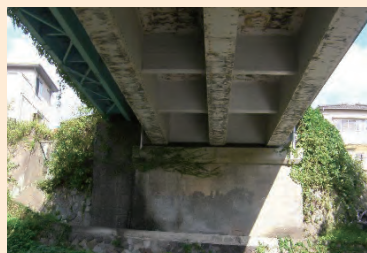
塗装の塗り替えによる橋梁の長寿命化(別府山香線 御門橋)
