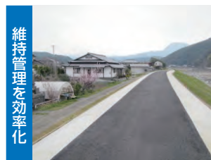
河川堤防天端の舗装
