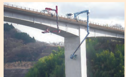
橋梁の定期点検
