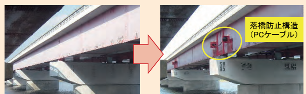
耐震性能基準を満たさない橋梁の耐震補強 (大分大分港線 弁天大橋)
