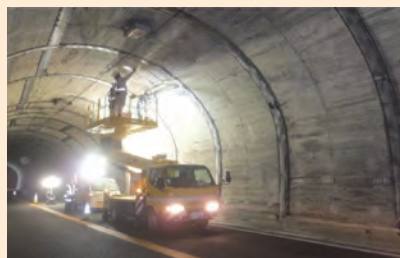
トンネルの定期点検
