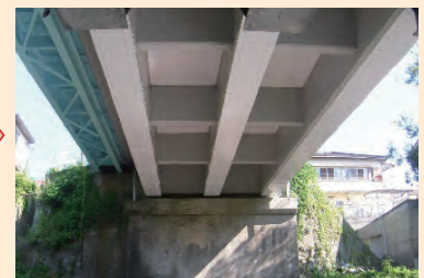
塗装の塗り替えによる橋梁の長寿命化(別府山香線 御門橋)
