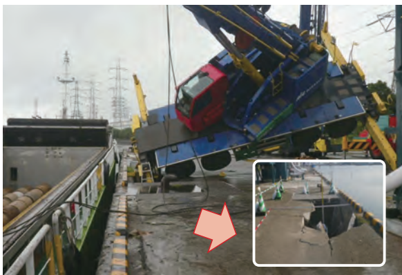
昭和38年完成(50年経過施設) 大分港(鶴崎地区)陥没事故(平成25年9月)
