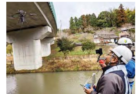
ドローンによる橋梁点検
