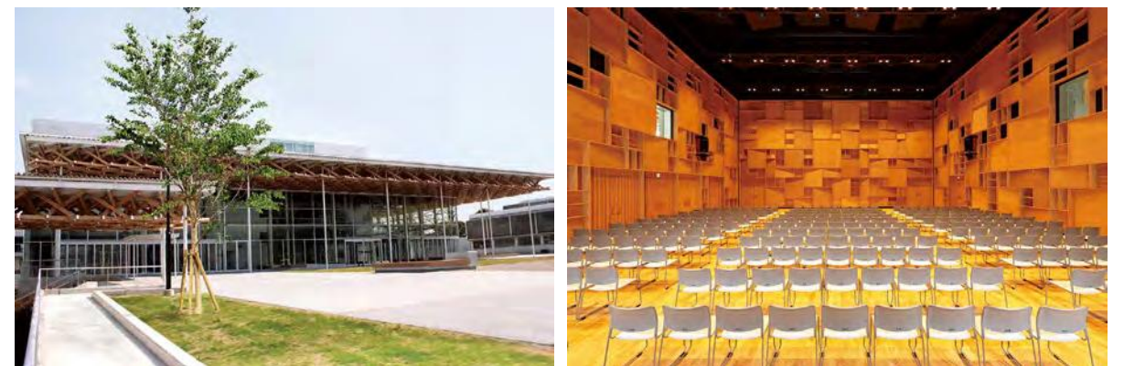
芸術文化短期大学 改修後の音楽ホール棟
