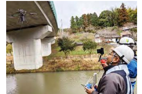
ドローンによる橋梁点検
