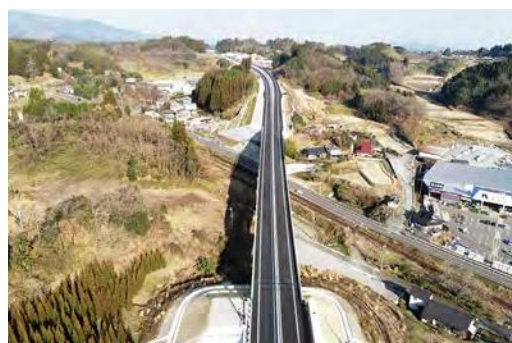
整備が進む中九州横断道路(大野竹田道路)
