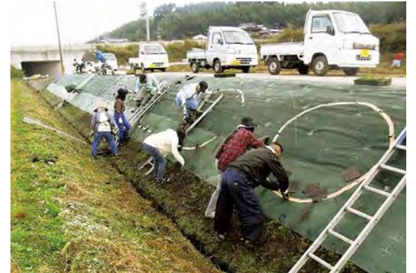
地域住民の共同活動によるほ場の法面の保全
