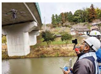
ドローンによる橋梁点検
