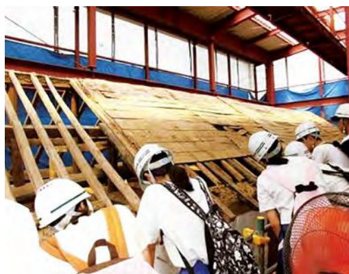
文化財修復現場公開(草野家住宅)
