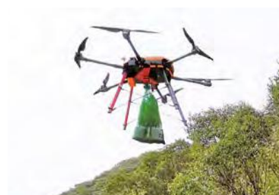
ドローンを活用した資材運搬
