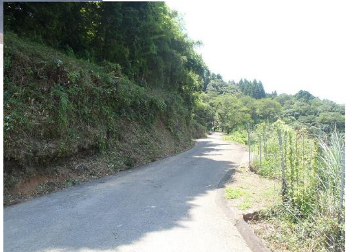
作業後の様子
