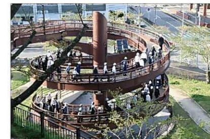
避難訓練 白杵公園ループ橋
