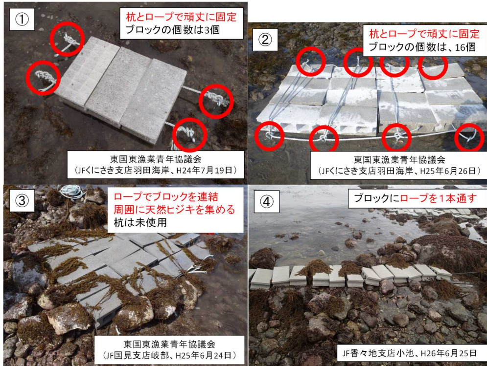
図Ⅱ-15 現場でのブロックの設置状況の例
