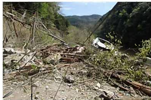
・国道212号被害（日田市）
