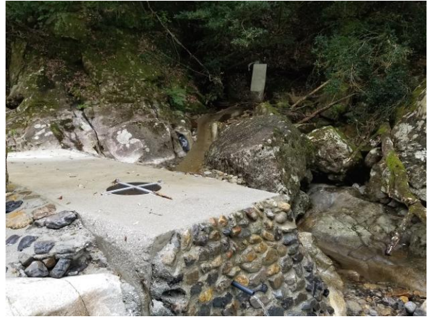
取水・貯水設備
