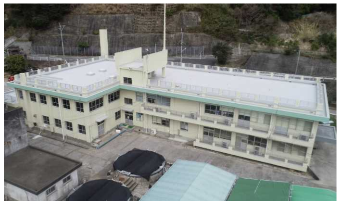
写真 水産研究部 本館 外装改修工事(令和2年2月)
