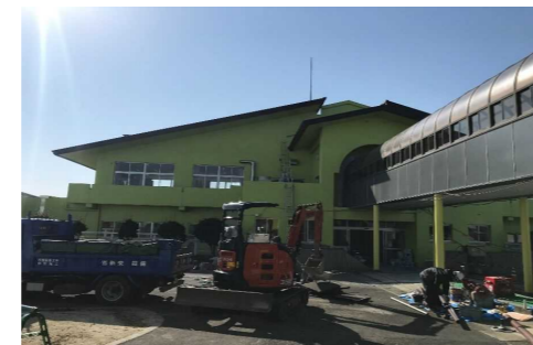
別館宿泊棟の工事完了まであとわずか
