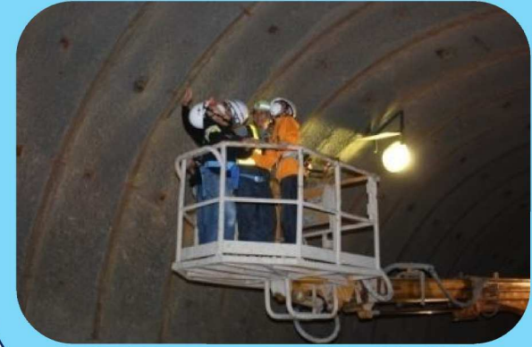
コンクリート、カッチカチやぞ！
