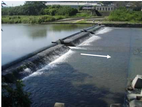
写真 2-1 水道用水を取水している堰（潮止め堰） （八坂川：杵築市八坂）
