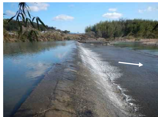
写真 2-2 農業用水を取水している川北井堰 （八坂川：杵築市八坂）
