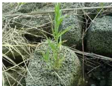
写真 2-21 コンクリートブロックの細かな孔に根が進入し成長したウラギク
