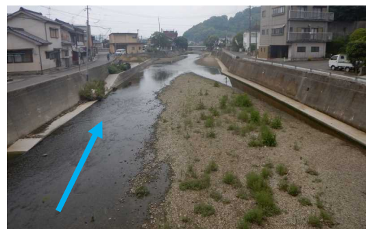
下岩屋橋より下流を望む ※矢印は川の流れの方向を示す。
