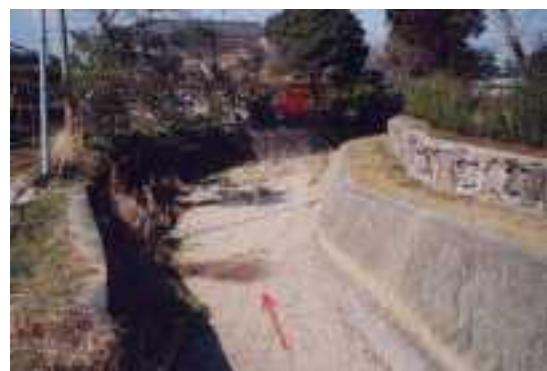
写真9 大谷川の冬場の状況（杵河内橋付近）
