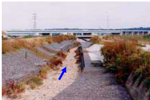
写真11 整備状況 (0k/200 付近)
