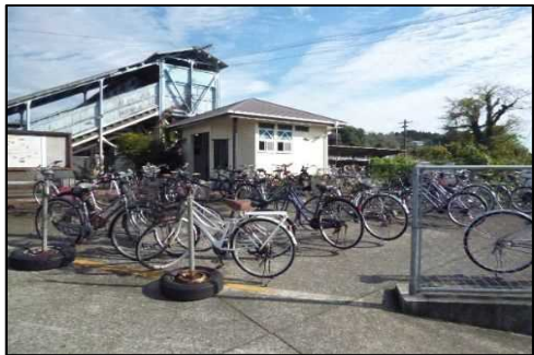
JR三重町駅（整備中） 駐輪スペースが不足
