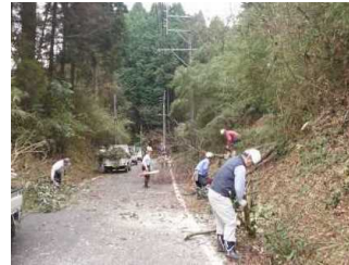
土木事務所は交通誘導や伐採のお手伝い！
