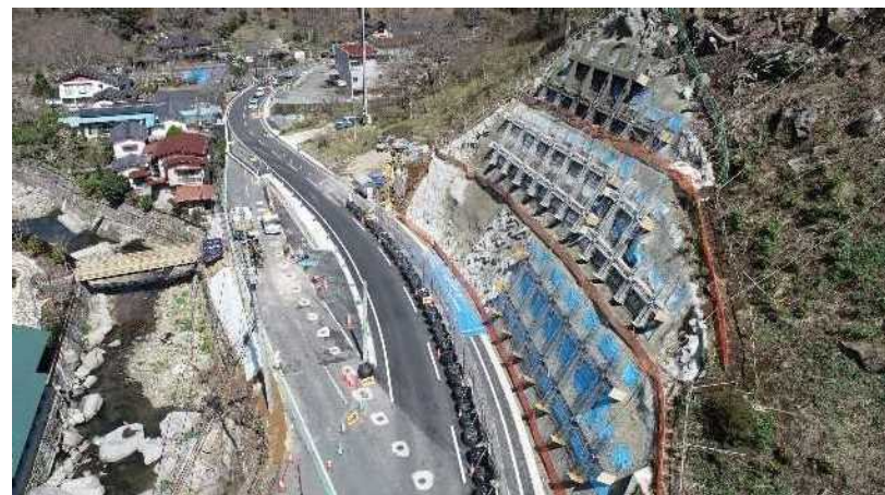
▼国道387号川底工区 整備中の状況
