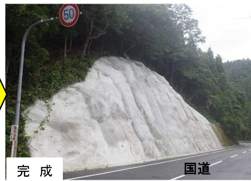
(国)国道387号(菅原工区) モルタル吹付補修工事
