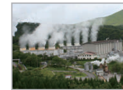
八丁原地熱地熱発電所 地熱学習
