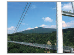
九重夢大吊橋
