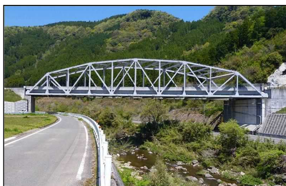
鋼橋（山移大橋）
