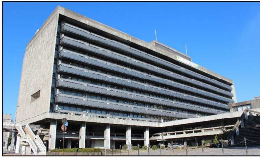
庁舎等(県庁舎本館)
