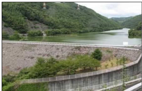
ロックフィルダム(鍋倉ダム)
