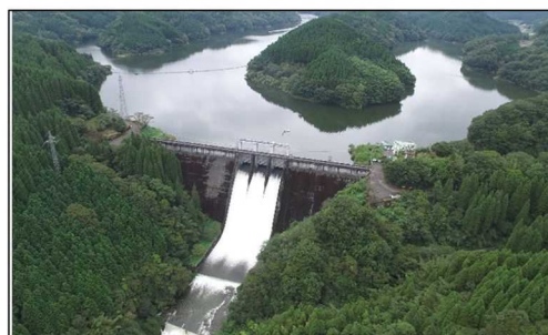
ダム(芹川ダム)
