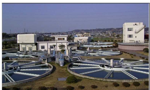
浄水場(大津留浄水場)
