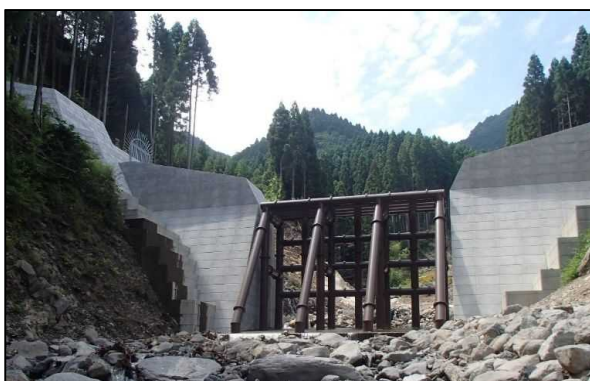
砂防設備（志谷川砂防堰堤）
