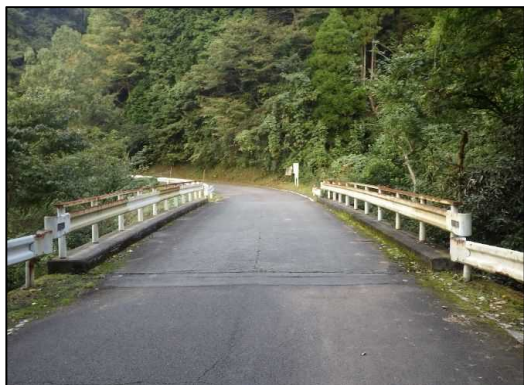
林道橋（御座ヶ岳線塚野山橋）
