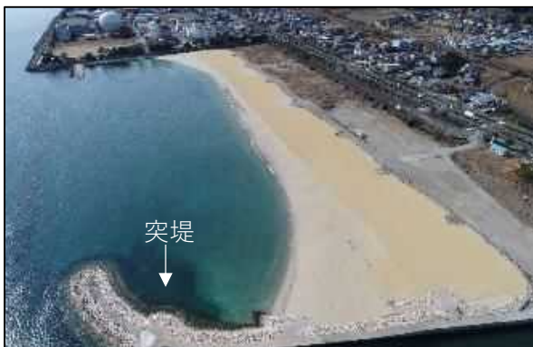
突堤（別府港海岸(関の江地区)）
