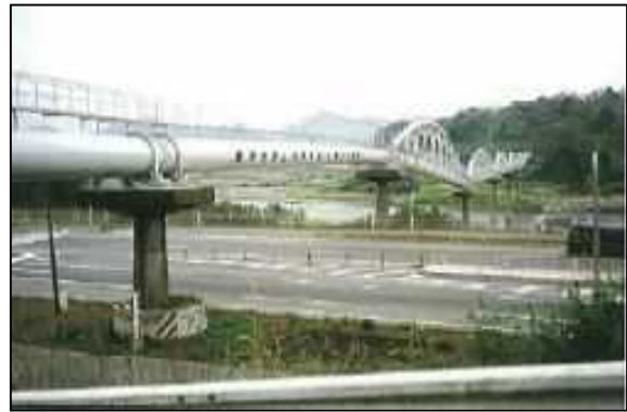
パイプライン〔昭和井路(大野川水管橋)〕
