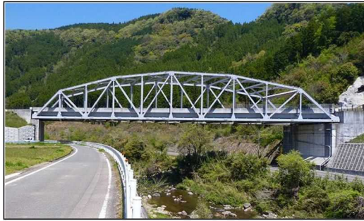
橋梁(山移大橋)
