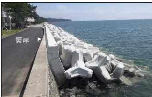
護岸（守江港海岸(住吉浜地区)）
