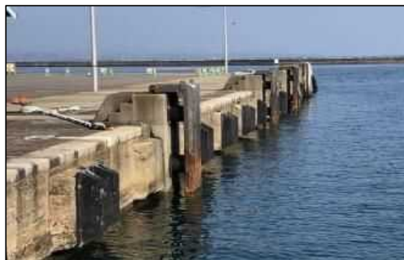
係留施設[岸壁]（別府港(石垣地区)）
