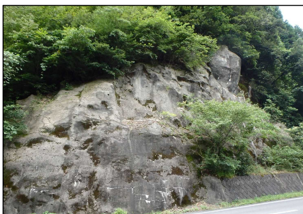
モルタル・コンクリート吹付（玖珠山国線）
