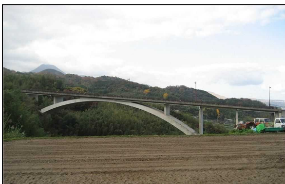
コンクリート橋（鳥越大橋）
