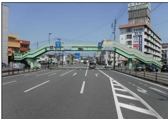
横断歩道橋（奥田横断歩道橋）
