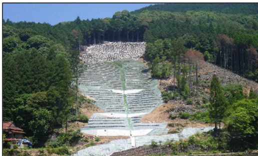
山腹工(東原地区)
