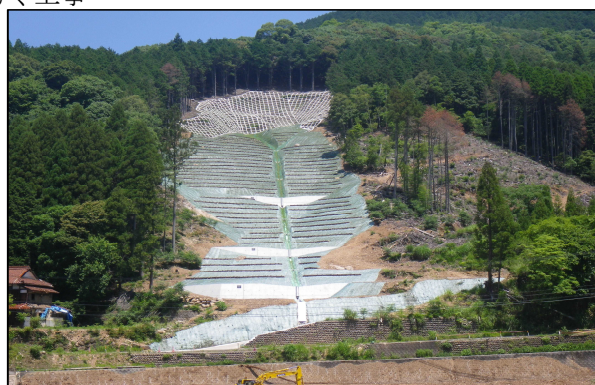
山腹工(東原地区)
