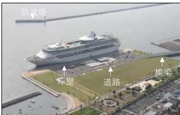
外郭施設[防波堤]等（別府港(石垣地区)）
