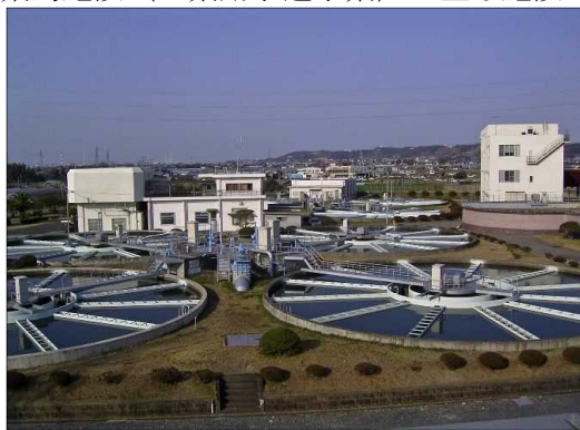
浄水場（大津留浄水場）
