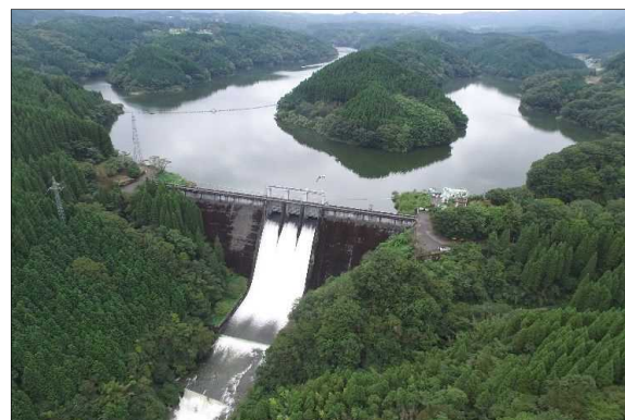
ダム（芹川ダム）
