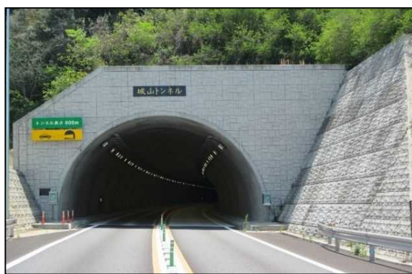
城山トンネル
