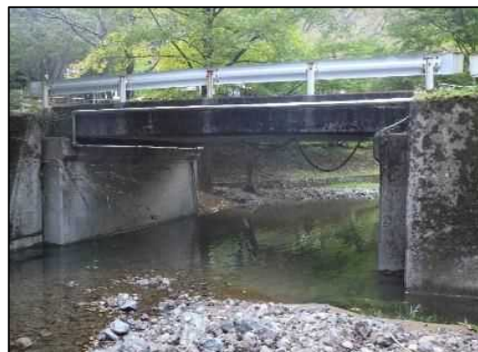
林道橋（御座ヶ岳支線1号橋）
