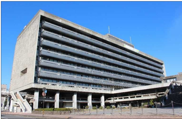
庁舎等（県庁舎本館）
