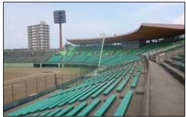
運動施設[野球場](大洲総合運動公園)
