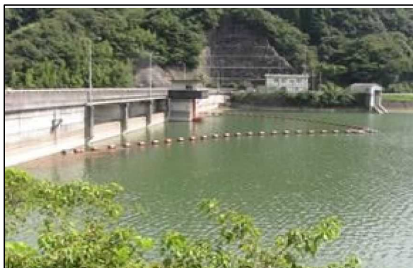
コンクリートダム(香下ダム)
