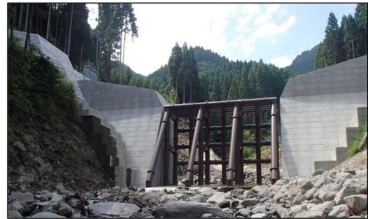
砂防施設(志谷川砂防堰堤)
