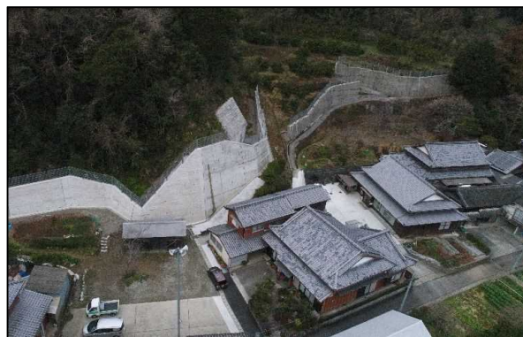
急傾斜地崩壊防止施設（代後3号地区）
