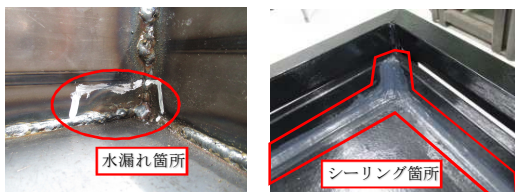
図6 補修 (左：漏れ箇所, 右：シーリング)
